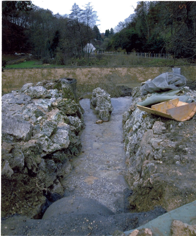
Kaskade 2: Der Blick schweift vom Damm des mittleren Weiher über die Kaskade Richtung Westen zur Mühle. Dort, wo früher eine trockene Rinne war, fließt nun wieder Wasser aus dem mittleren Weiher via Überlaufbecken und Wasserfall in den unteren Weiher.
